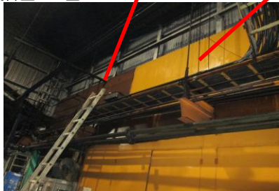
制御盤上の壁 清掃前 清掃後
