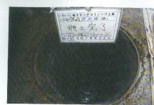
FRP内面ライニング 完了 (前上)
