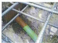
配管工事 ベトナム管の着き
