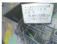
配管工事 ベトナム管の着き
