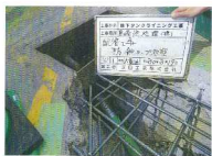
配管工事 防蝕剤の塗布
